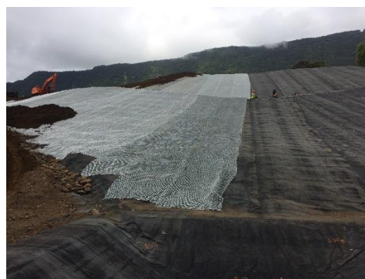
Déploiement sur les talus
