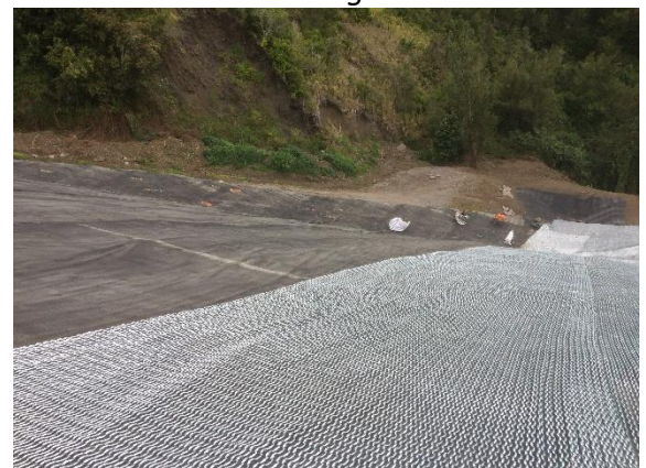
Vue depuis la crête de talus
