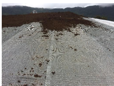
Remblaiement sur l'accroche-terre
