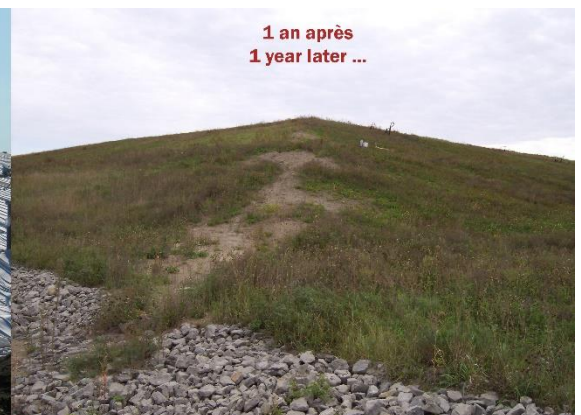
Drainage des eaux de pluies sur géomembrane - 2009 Rainwater drainage on a cap - 2009
