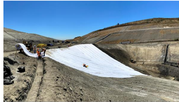
Installation du DRAINTUBE 303P FT4 D25 pour la collecte des biogaz sous la géomembrane. Chaque panneau de DRAINTUBE® est relié au suivant au moyen de connecteurs.
