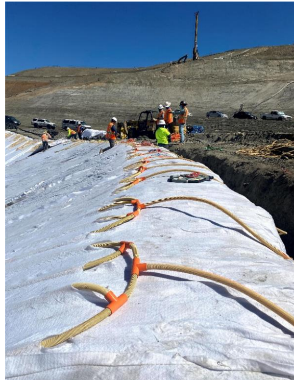
Le DRAINTUBE® possède des mini-drains perforés espacés tous les 250 mm de largeur de produit. Ils sont connectés au réseau de collecte de biogaz et mis en pression négative.
