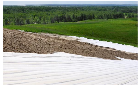
Mise en œuvre du matériau de remblai sur le DRAINTUBE®. Le géocomposite permet également de protéger la géomembrane contre le poinçonnement.
