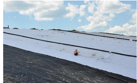
Installation du DRAINTUBE 300P FT4 D25 pour le drainage des eaux de pluie sur la géomembrane. Les rouleaux sont associés entre eux par couture ou soudure.
