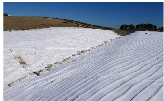
DRAINTUBE 500P FT4 D25 est installé sur la géomembrane pour drainer les eaux de ruissellement et la protéger.
