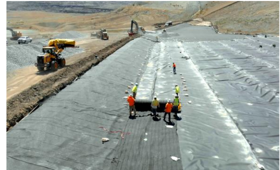
Installation manuelle du DRAINTUBE 606 ST1 D20 sur une géomembrane PEHD de 60 mil, composant le SCL. Les rouleaux légers sont plus faciles et plus rapides à installer.
