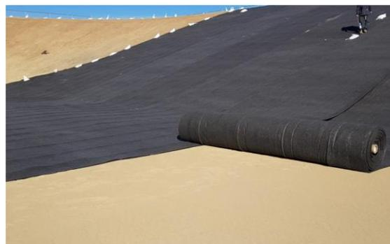
Installation du DRAINTUBE 606 ST1 D20 pour le captage des gaz sous l'étanchéité secondaire. Le DRAINTUBE® est connecté au drain périphérique avec le système Quick Connect.
