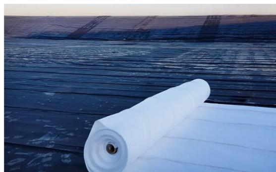
Installation du DRAINTUBE 400P FT1 D20 Conductive pour le drainage des fuites entre les deux géomembranes. Sa partie supérieure est conductrice d'électricité.
