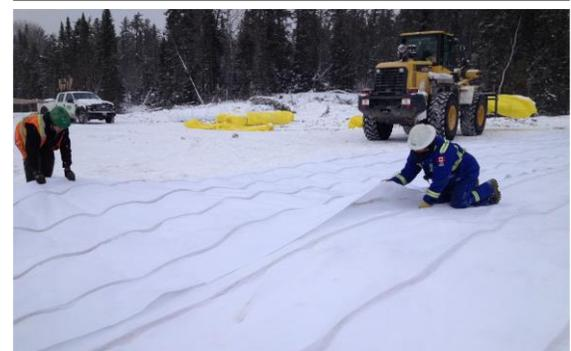
Installation du DRAINTUBE 400P FT1 D25 en hiver. Les résidus faiblement porteurs présentent une meilleure résistance lorsque gelés à -25°C.
