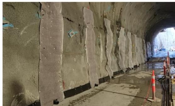
Bandes d'ALVEODRAIN EV fixées mécaniquement pour le drainage vertical des parois du tunnel
