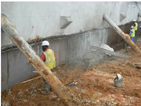
Pose du ferrailage
