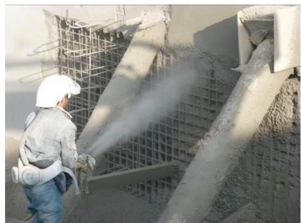
Projection du béton
