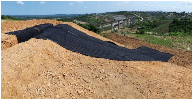
Déploiement dans les talus et tranchées d'ancrages
