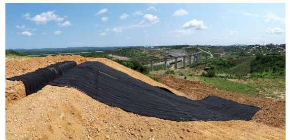
Déroulage du SOMTUBE FTF dans le talus et tranchée d'ancrage
