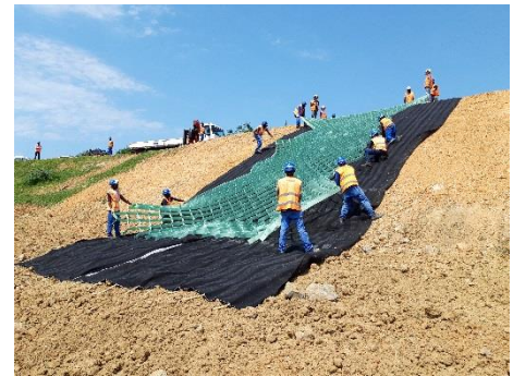
Déploiement dans les talus et tranchées d'ancrages
