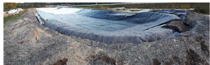
Installation et soudure de la géomembrane sur le DRAINTUBE
