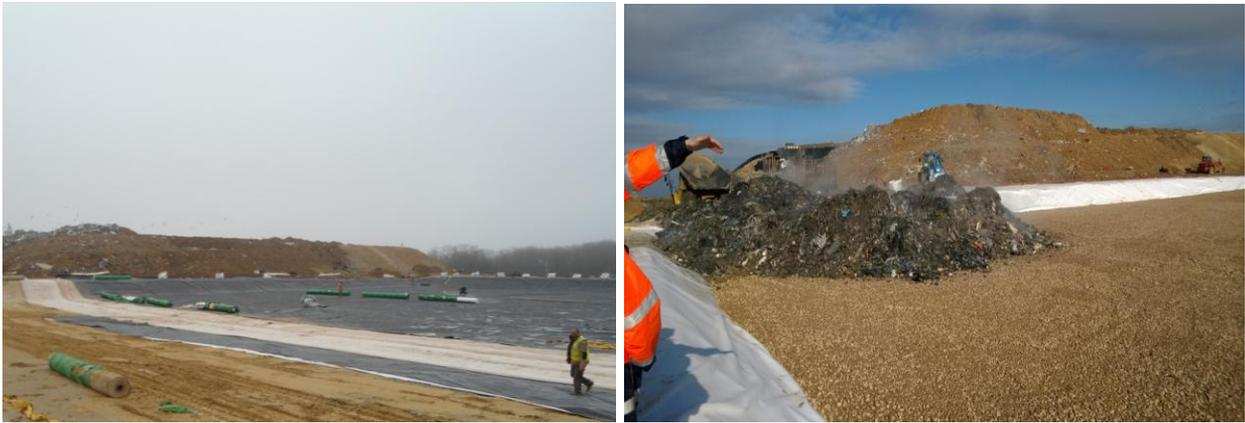
Figure 3. Pose du Geoter FPET et mise en place des déchets (Sources : Egis et Texinov)
