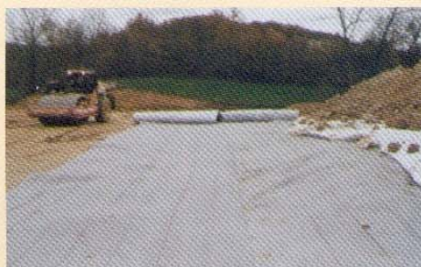
Photo 1 Déroulement du géocomposite de drainage sur le fond de forme Unrolling the drainage geocomposite over the subgrade
