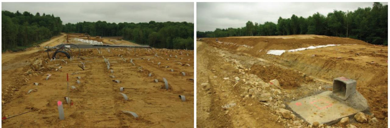
Figures 8 et 9. Montée du remblai
