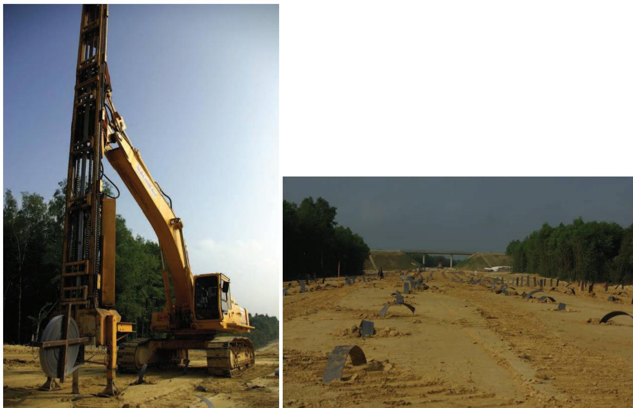
Figures 3 et 4. Mise en place des drains verticaux
