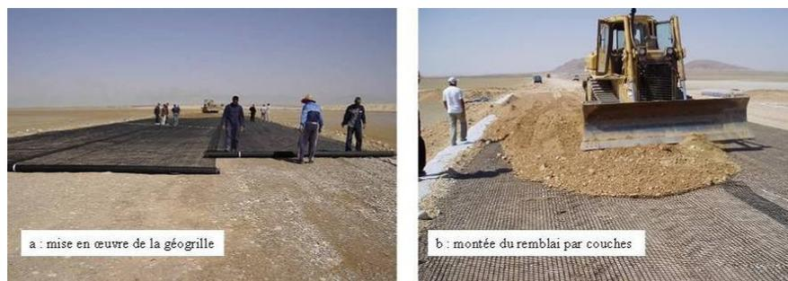
**Figure 11.** Mise en place de la géogrille
