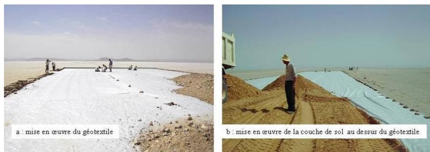
**Figure10.** Mise en place du géotextile
