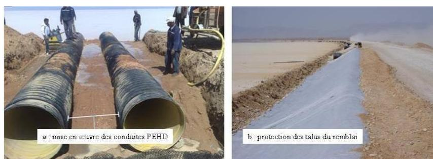
**Figure 12.** Mise en place des conduites PEHD (a) et protection des talus (b)
