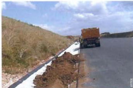
Photo 7 Recharge en excès de terres végétales Overlaying with topsoil
