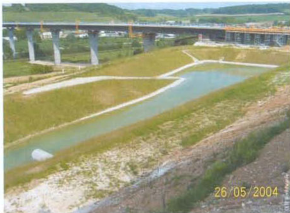
Photo 3 Viaduc de la Bresle en cours de construction et bassins de traitement Bresle viaduct under construction and treatment basins
