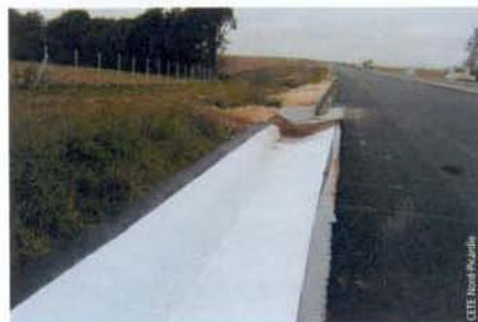
Photo 5 Mise en œuvre du Stabiliner Alveo Application of Stabiliner Alveo
