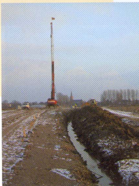
Photos 3 et 4 Mise en œuvre des drains Drain laying
