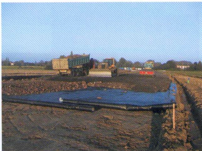
Photo 1 Piste et chemin en recyclé Track and path of recycled materials
