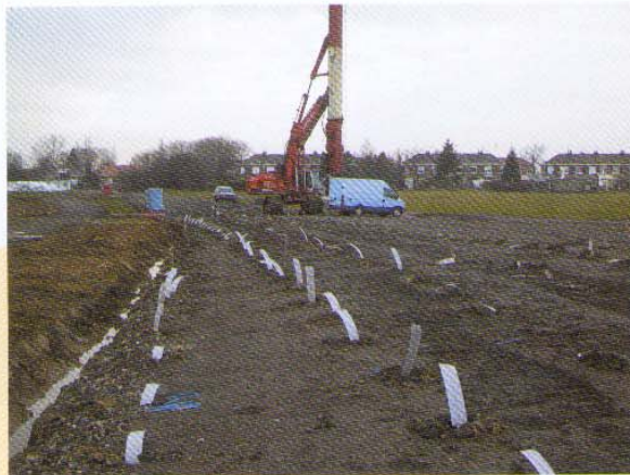
Photos 3 et 4 Mise en œuvre des drains Drain laying
