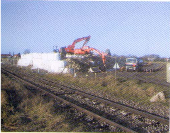
Photos 7 et 8 Réalisation du mur de soutènement
