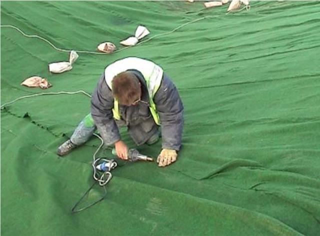
Figure 8 : Soudure des joints à l'air chaud
