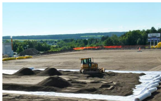
Mise en œuvre du matériau de remblai sur le DRAINTUBE®
