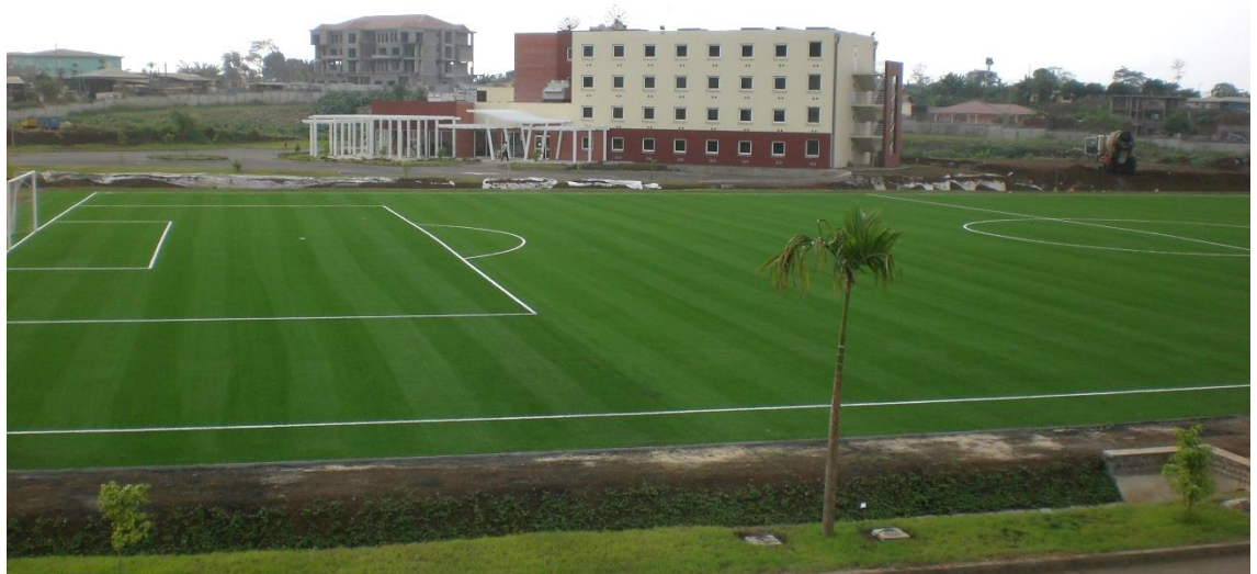
Construction du terrain de soccer FIFA – Malabo – 2009
