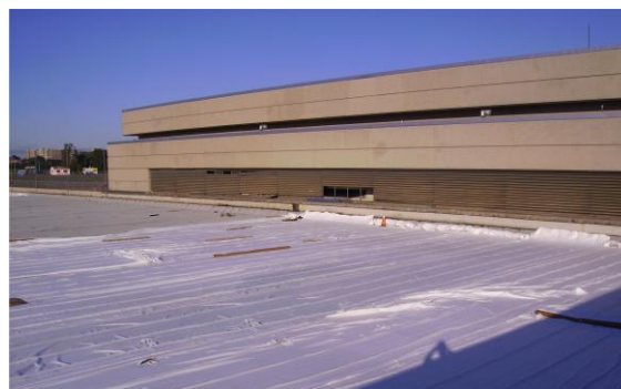
Installation du DRAINTUBE® sur le sol en place
