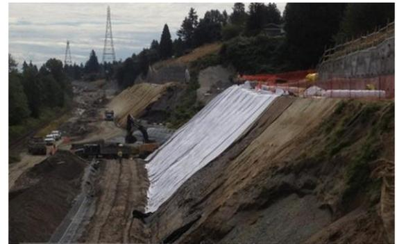
Construction du mur de soutènement, mise en œuvre et compactage du remblai renforcé.
