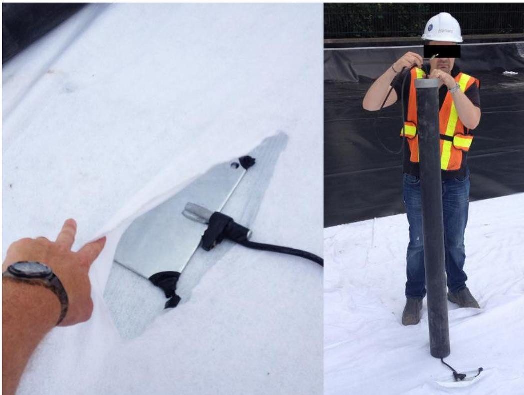
Figure 9 : Exemple d'un accès permanent au GEOCONDUCT®/DRAINTUBE® Conductive
