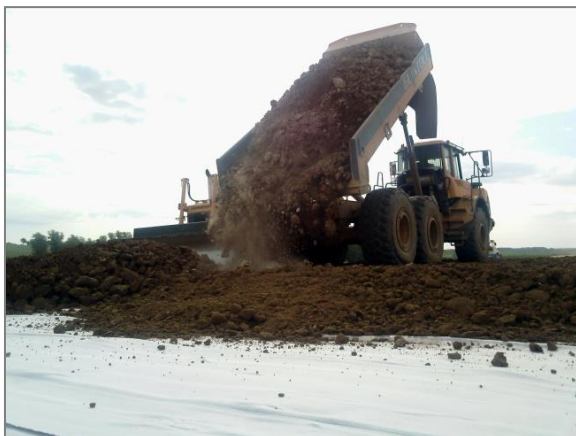
Figures 15: Mise en place du remblai
