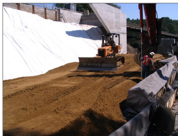
Figures 16: Mise en place du remblai – Masque drainant et Mur renforcé
