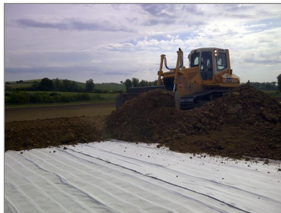
Figures 15: Mise en place du remblai
