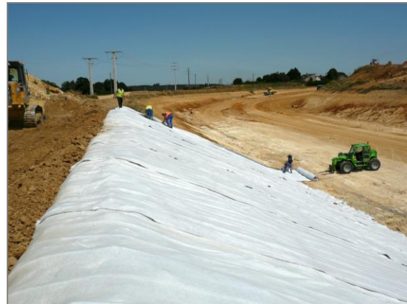
Figures 5: Installation du DRAINTUBE® en talus
