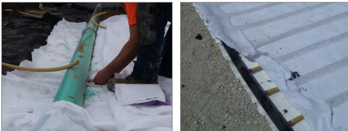
Figures 13: Connexion au drain collecteur avec le système Quick Connect
