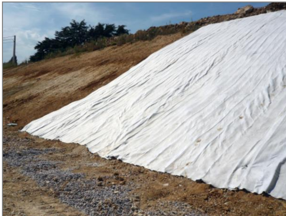
Figures 5: Installation du DRAINTUBE® en talus
