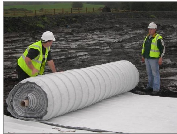
Figures 3: Mise en œuvre du DRAINTUBE®
