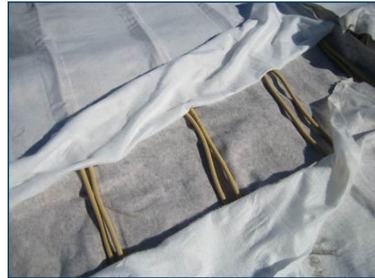
Figures 5: Joints transversaux sans connecteurs
