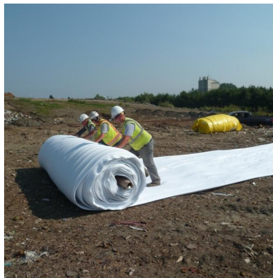
Installation du DRAINTUBE™
