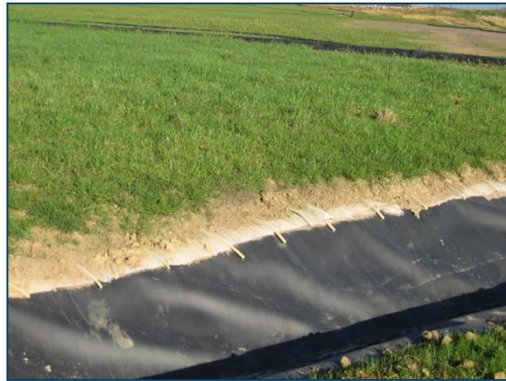
Figure 10: Raccordement à un fossé
