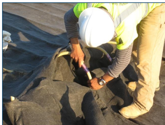
Figure 7: Mise en place des connecteurs
