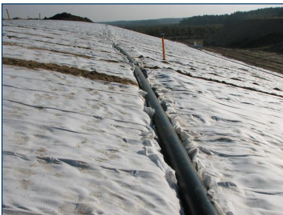
Figures 14: Raccordement à un drain lisse avec le système Quick Connect™
