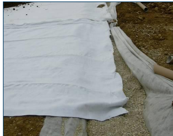
Figures 9: Raccordement à une tranchée collectrice
