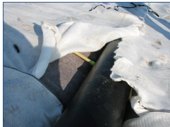
Figures 14: Raccordement à un drain lisse avec le système Quick Connect™
