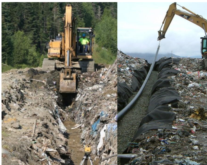
Tranchée collectrice traditionnelle
