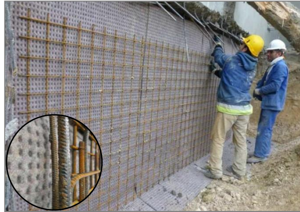
Figure 9: Installation de l'armature métallique
