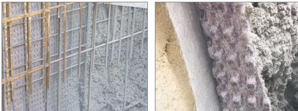
Figures 11: Adhésion du béton projeté sur l'ALVEODRAIN®
