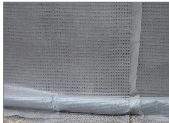
Figures 6: Raccordement au drain collecteur
