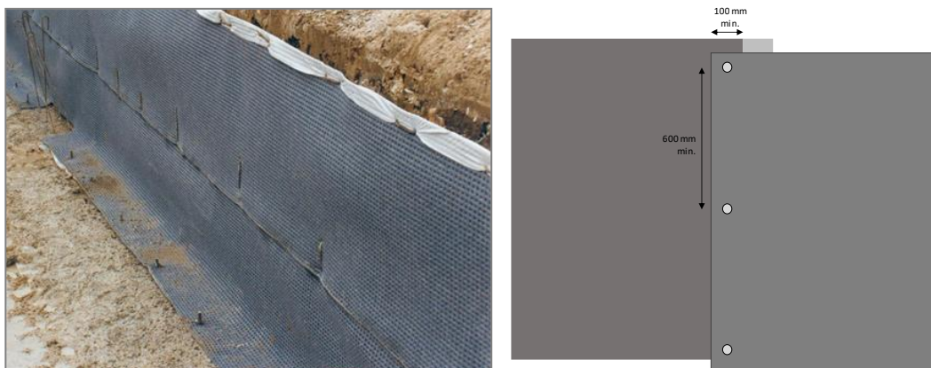
Figures 8: Mise en place du géocomposite en horizontal ou vertical
