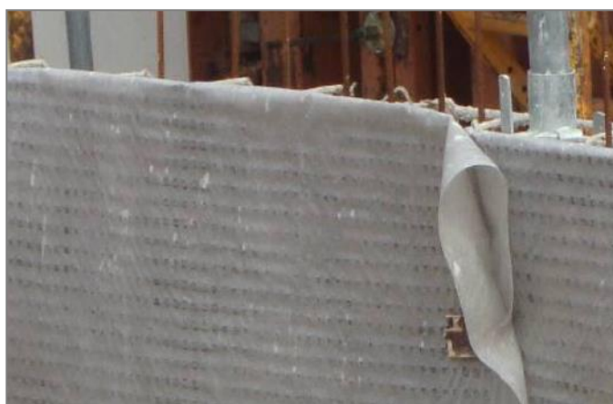
Figure 3: Installation de l'ALVÉODRAIN®
