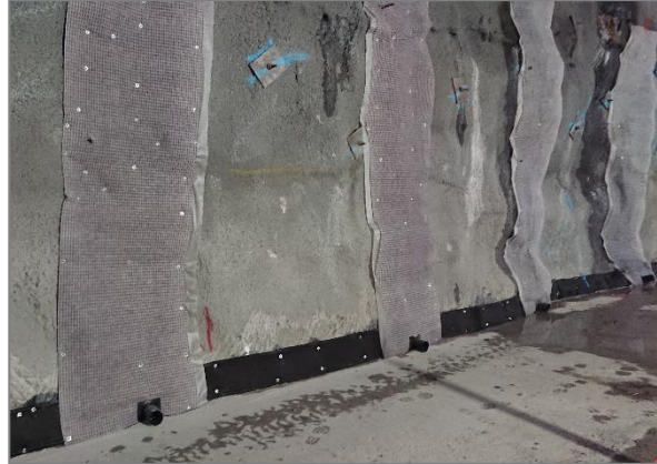
Figure 14: Sorties pour tuyaux
