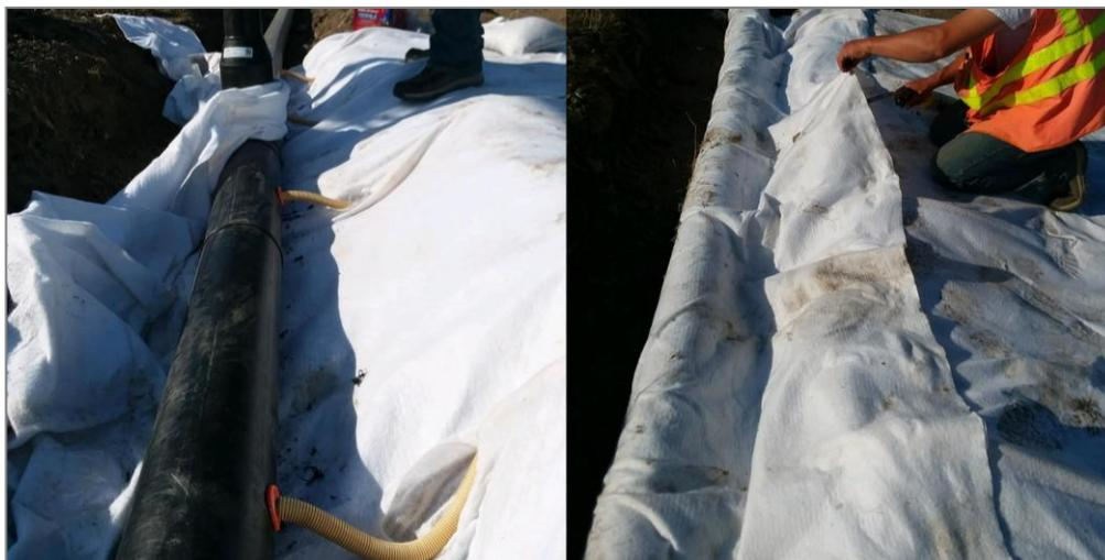
Figures 13: Connexion à la conduite avec le système Quick Connect
