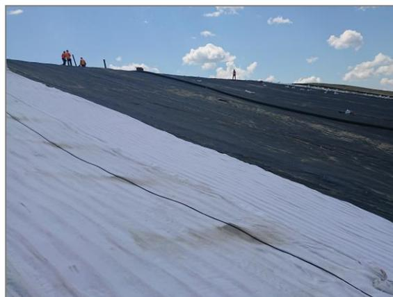
Figure 4: DRAINTUBE® sur géomembrane
