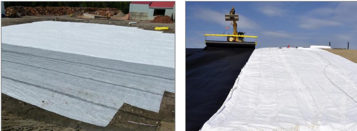
Figures 14: Installation d'un géosynthétique sur le DRAINTUBE®
