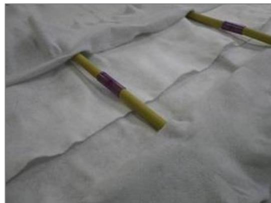
Figures 6: Connexions transversales avec connecteurs
