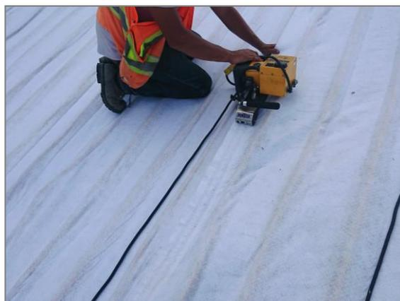
Figure 8: Connexions longitudinales
