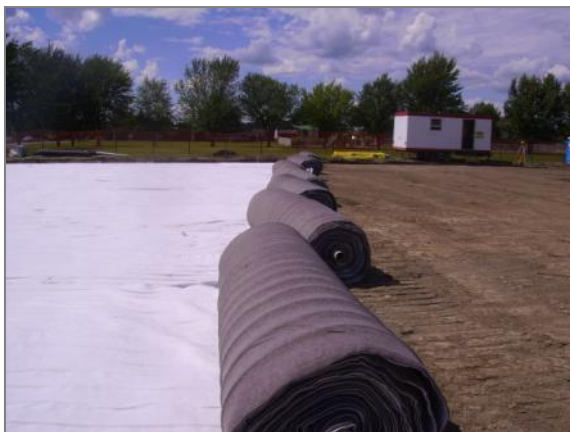
Figures 3: Mise en œuvre du DRAINTUBE®
