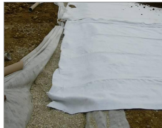
Figures 7: Raccordement à une tranchée collectrice
