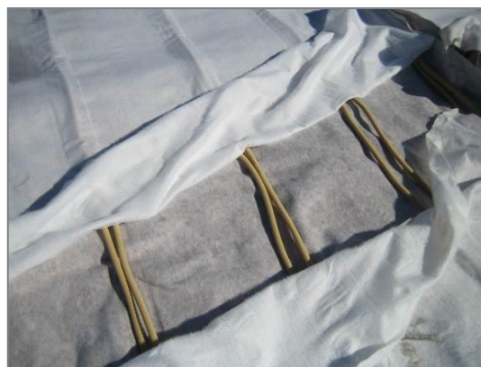
Figures 4: Connexions transversales sans connecteur
