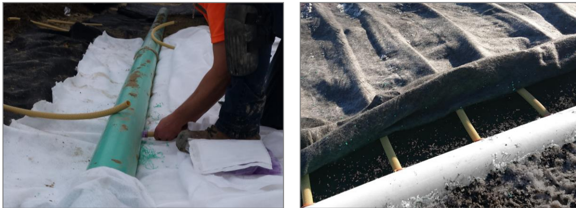
Figures 9: Connexion au drain collecteur avec le système Quick Connect
