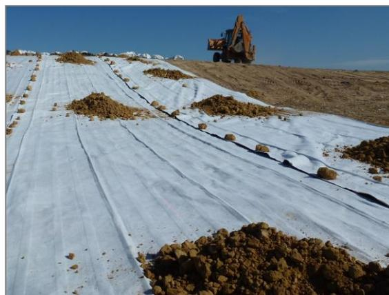
Figure 4: Installation du DRAINTUBE® FTP
