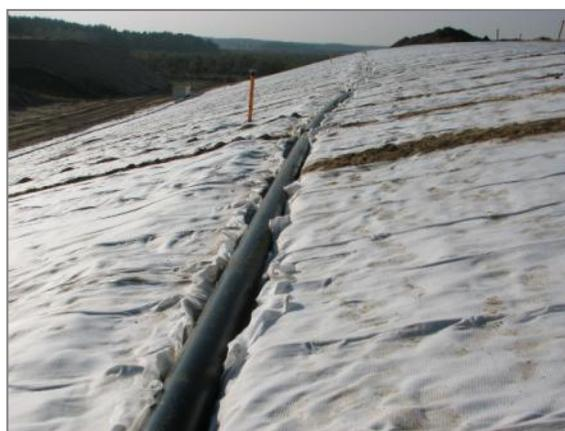
Figure 12: Connexion à la conduite avec le système Quick Connect
