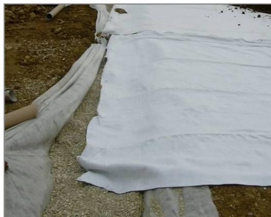
Figures 8: Raccordement à une tranchée collectrice
