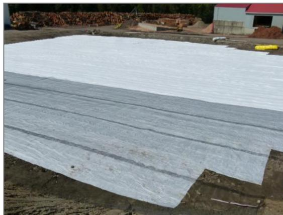
Figure 13: Installation d'un géosynthétique sur le DRAINTUBE® FTP
