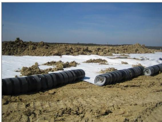
Figure 3: Rouleaux de DRAINTUBE® FTP
