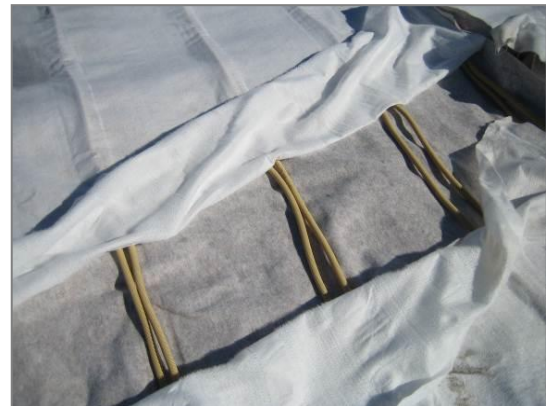
Figures 4: Connexions transversales sans connecteur
