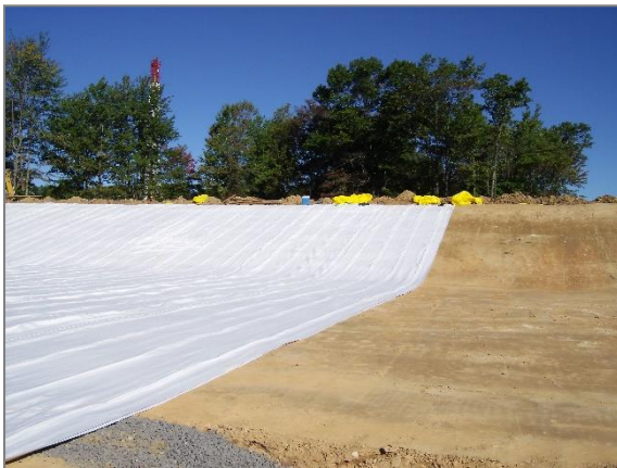
Figures 3: DRAINTUBE® sur sol en place
