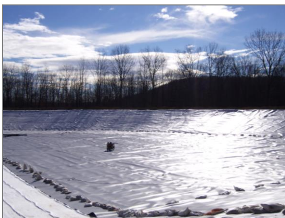
Figures 12: Installation de la géomembrane
