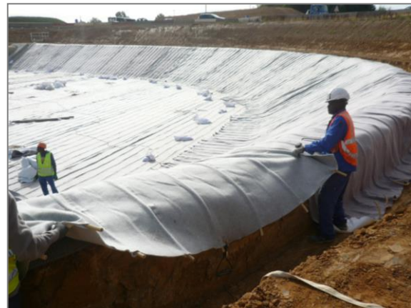
Figures 3: DRAINTUBE® sur sol en place
