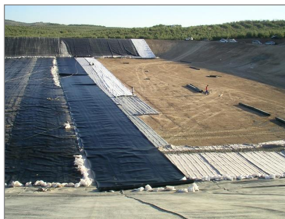
Figures 12: Installation de la géomembrane
