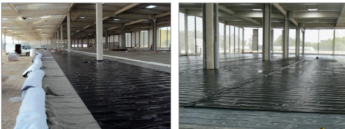
Figures 13: Installation d'un géosynthétique
