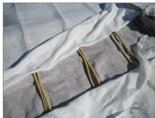
Figures 4: Connexions transversales sans connecteur
