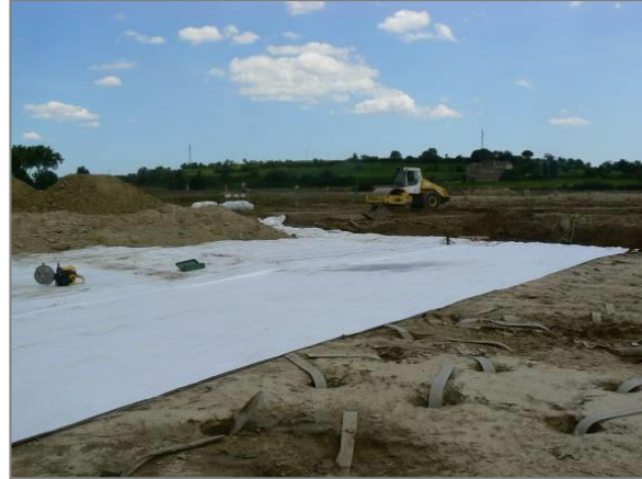
Figures 4 : Mise en place du DRAINTUBE® sur les drains verticaux
