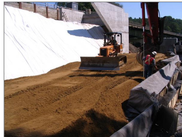
Figures 16: Mise en place du remblai – Masque drainant et Mur renforcé
