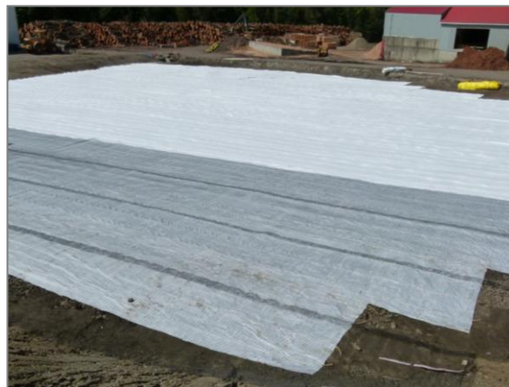
Figure 14: Installation d'un géosynthétique sur le DRAINTUBE®
