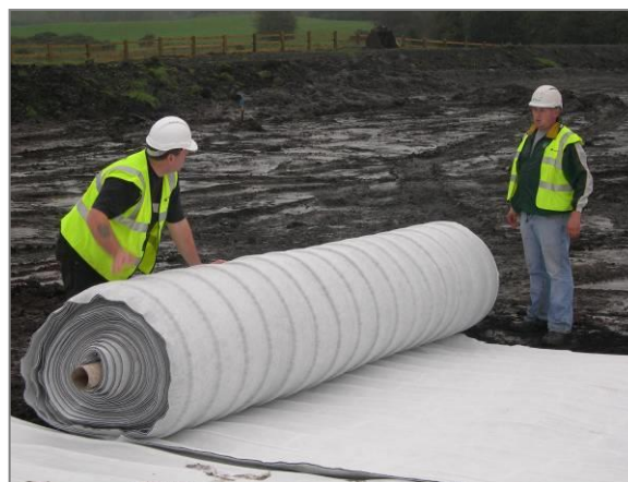
Figures 3: Mise en œuvre du DRAINTUBE®
