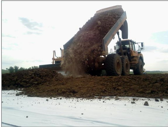
Figures 15: Mise en place du remblai
