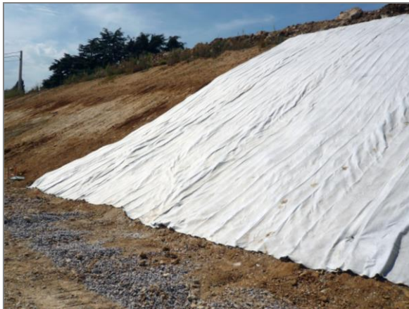
Figures 5: Installation du DRAINTUBE® en talus
