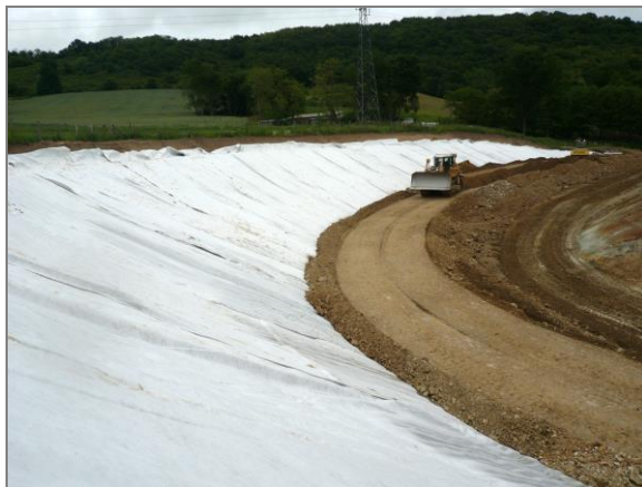
Figures 16: Mise en place du remblai – Masque drainant et Mur renforcé
