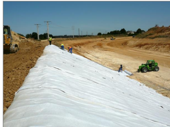
Figures 5: Installation du DRAINTUBE® en talus
