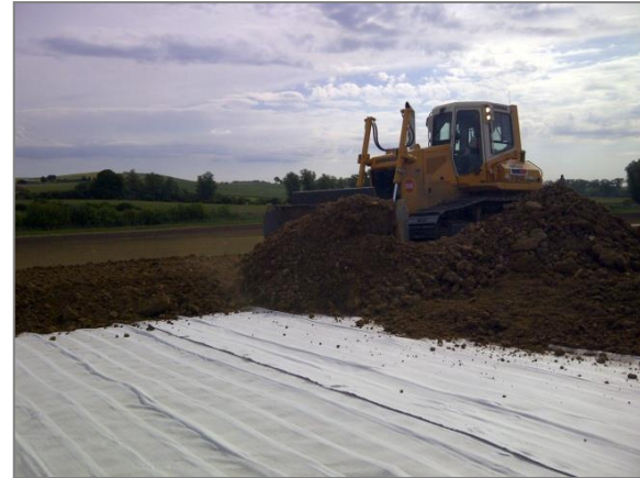
Figures 15: Mise en place du remblai
