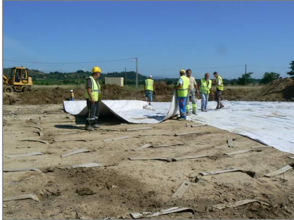
Figures 4 : Mise en place du DRAINTUBE® sur les drains verticaux
